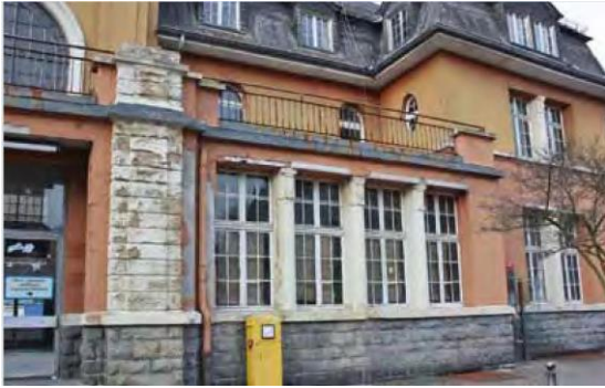
Abbildung 3: Werdohler Bahnhof vor der Sanierung, Quelle: Groß et al. 2013
