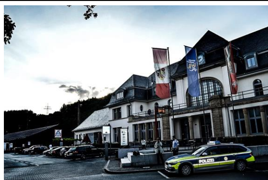
Abbildung 10: Werdohler Bahnhof nach der Sanierung, Foto: Iris Kannenberg, o.J.
