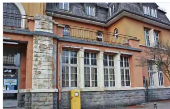
Abbildung 6: Werdohler Bahnhof vor der Sanierung, Quelle: Groß et al. 2013
