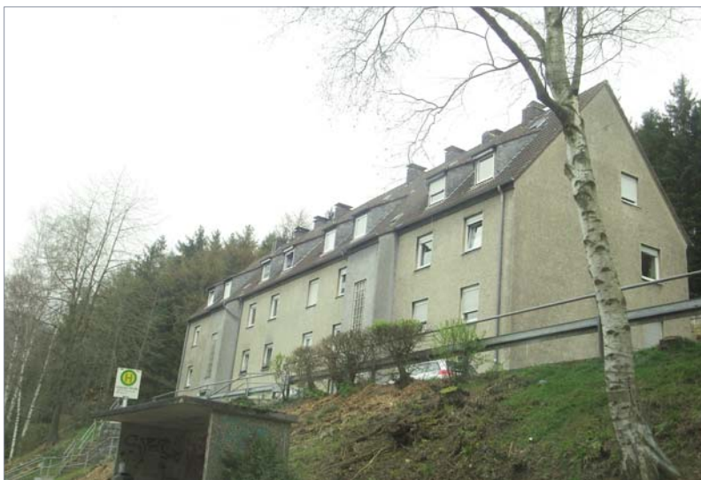
Abb. 50: Noch nicht modernisierter Bestand der Wohnungsgesellschaft Werdohl
