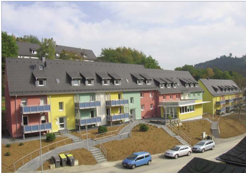
Abb. 49: Modernisierter Wohnungsbestand mit dem neu geschaffenen Nachbarschaftshilfezentrum
